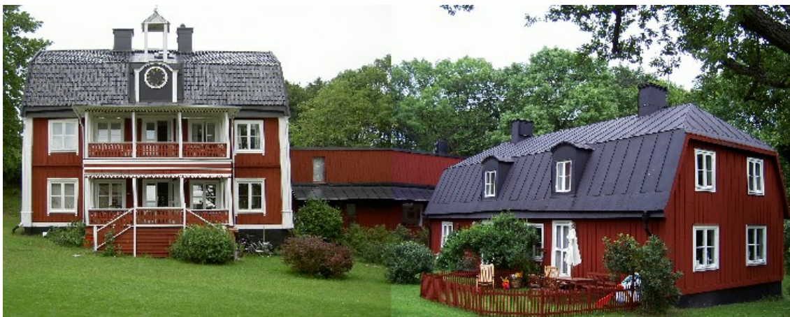
Bild3: Mölna Gård, Huvudbyggnad, ny komplementbostad och flygelbyggnaden
