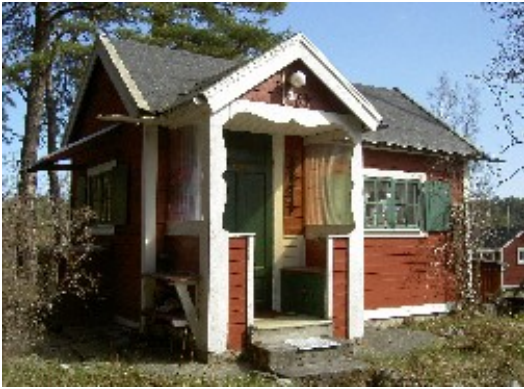
Byggnad 41 – Dalakolonins enda ursprungliga stuga utan sentida tillbyggnader.
