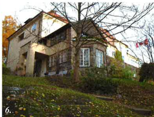
Stentrappa ned mot fastigheternas södra delar
