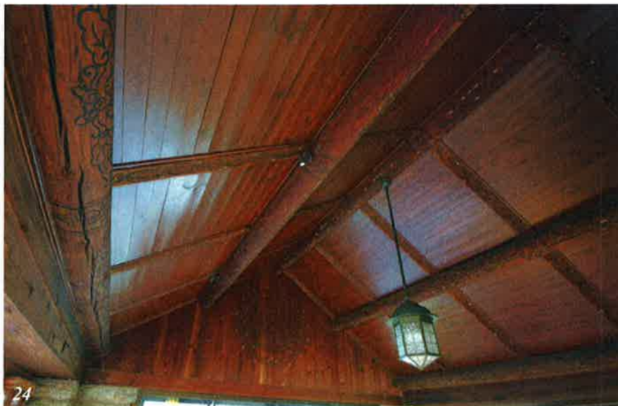
Bemålad takkonstruktion i sommarverandan
