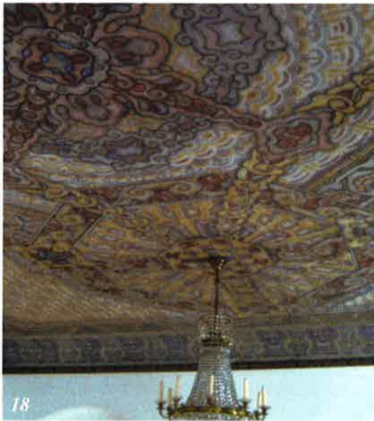
18 Takmålning i sällskapsrummet
