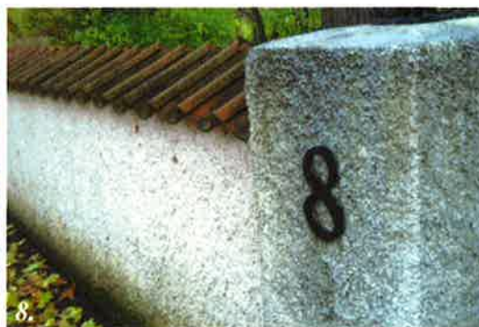
Mur mot Törnrosvägen
