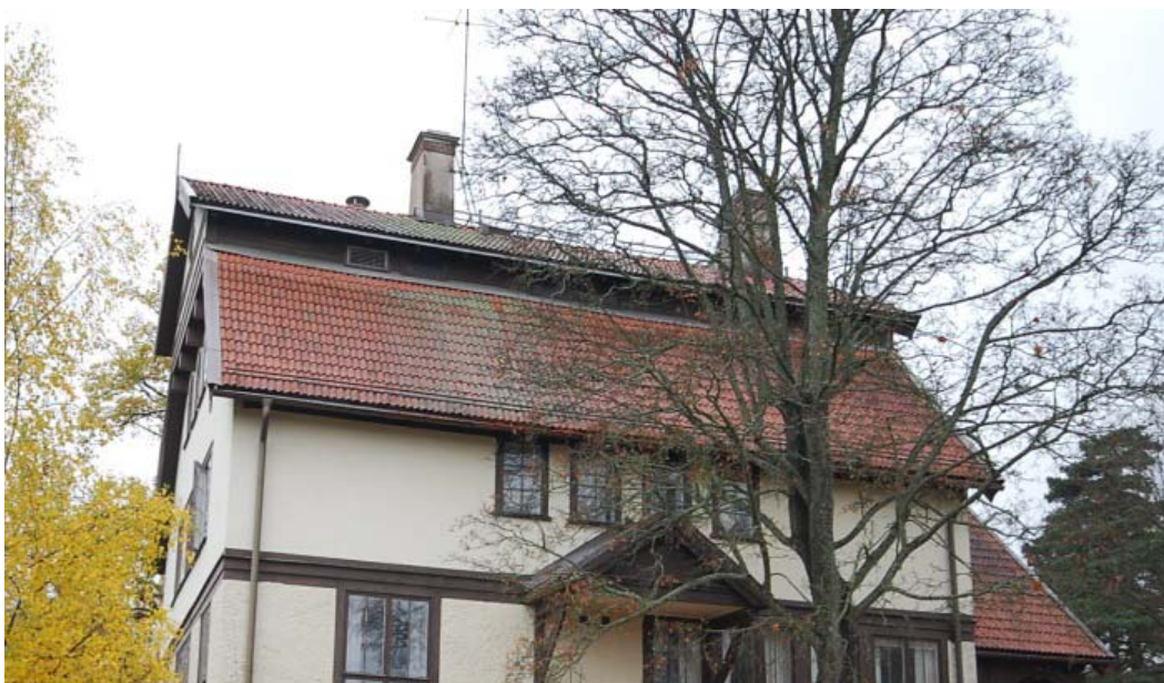
Östra fasaden. Tak täckt med rött tvåkupigt lertegel. Italianen med ursprungliga fönster.
