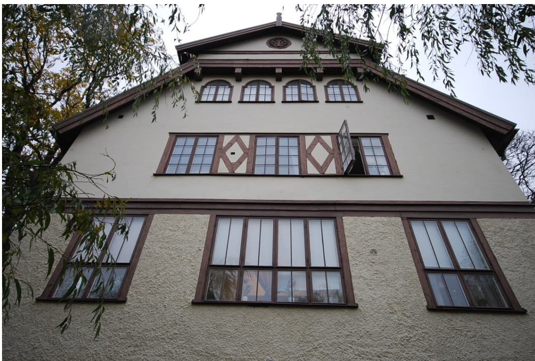
Södra fasaden. Befintlig fönsterutformning. Samtliga fönster ligger i fasadliv. Fasad slät- respektive spriputsad i blekt gul kulör. Bruna snickerier.
