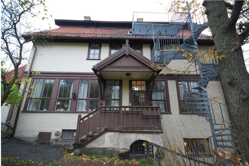
Västra fasaden. Entréveranda med skärmtak på konsoler. Ursprunglig entrédörr.
